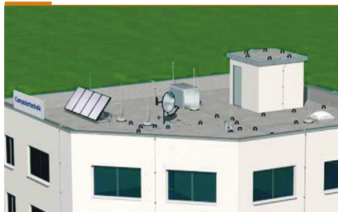
Фото 1. Крыша, оборудованная молниезащитой
